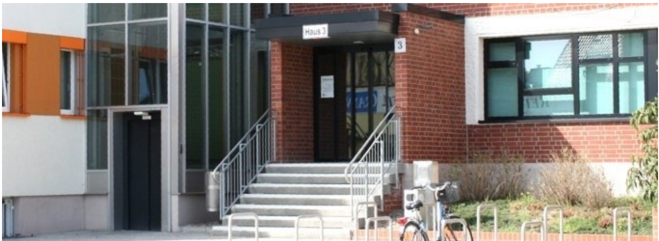
Ansicht Eingangsbereich Jobcenter Oberhavel, Bildquelle: www.oberhavel.de/B%C3%BCrgerservice/Arbeit-und-Beruf/Jobcenter
